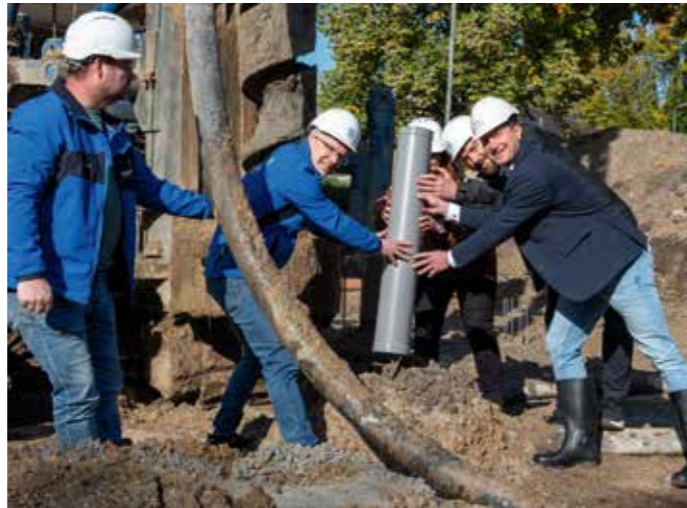
Bouwbedrijf Hendriks plaatst de eerste boorpaal en de tijdscapsule met persoonlijke herinneringen en bijdragen van bewoners
